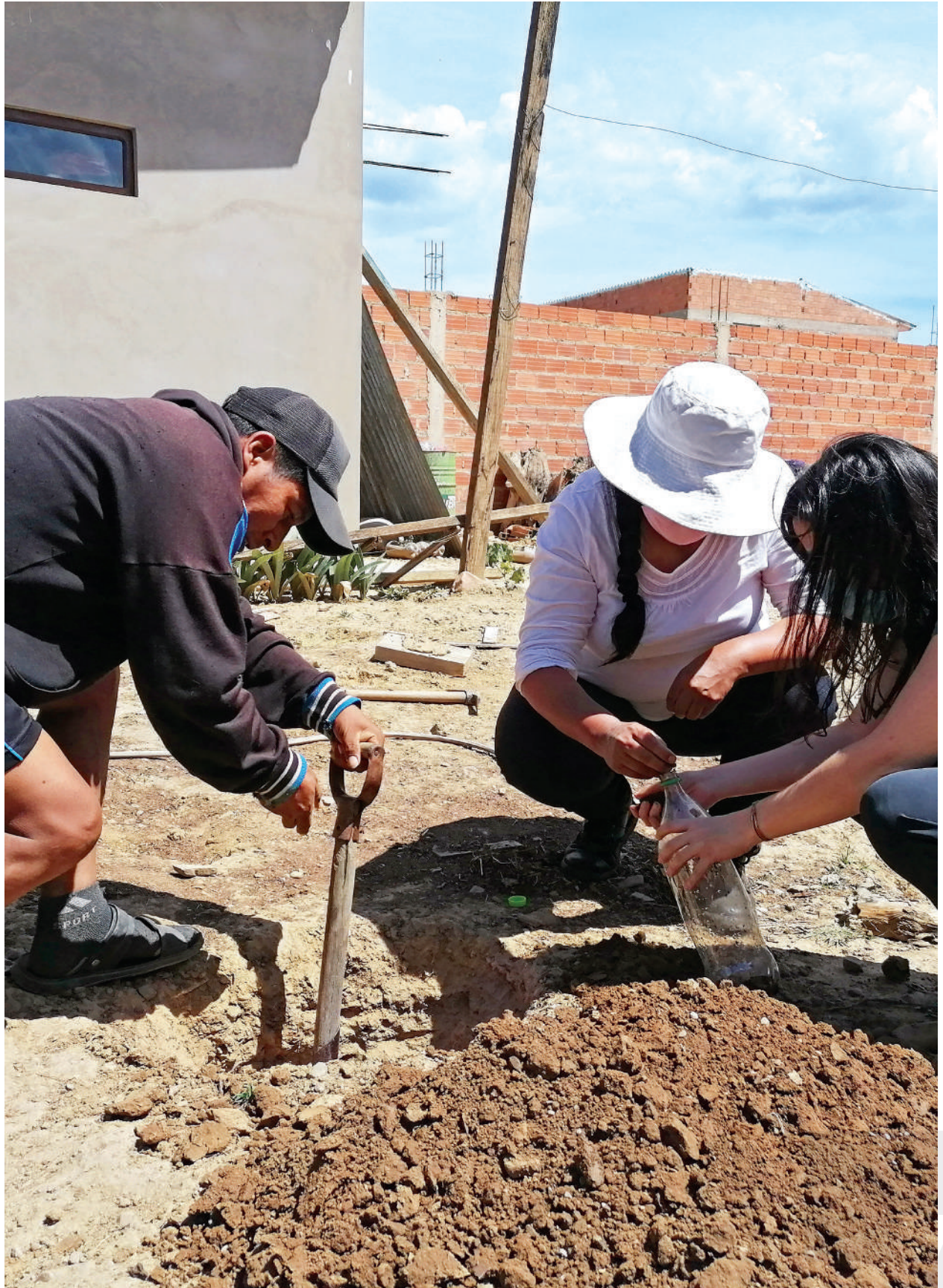
Ensayos preliminares sobre la tierra in situ
