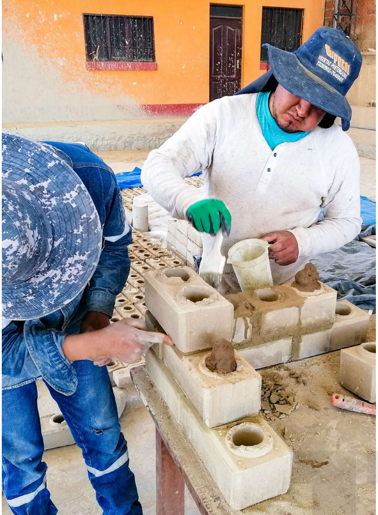
Ensayos de levantamiento de muro con BTC
